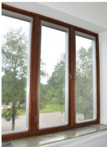
Bild 5 och 6. Inom röd markerat område på bilden ovanför visas de befintliga metallfönster med rundade hörn som ska bibehållas till sin utformning. Bild 6 till vänster visar fönsternas utformning med träkarm på insidan.
